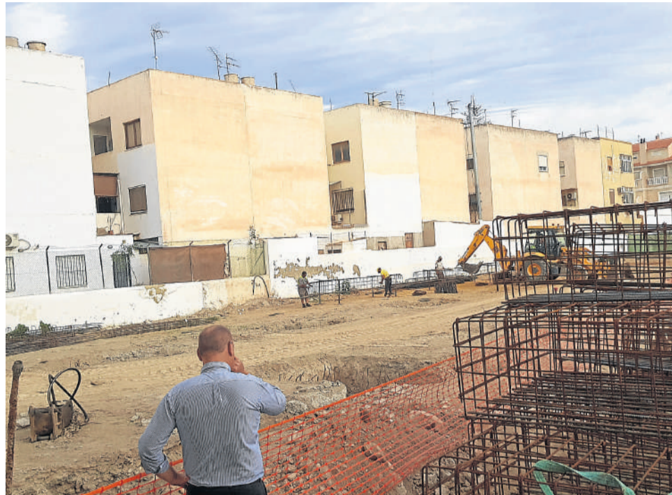
El alcalde comprueba las obras en el colegio Álvarez de Sotomayor en su visita al centro escolar.
